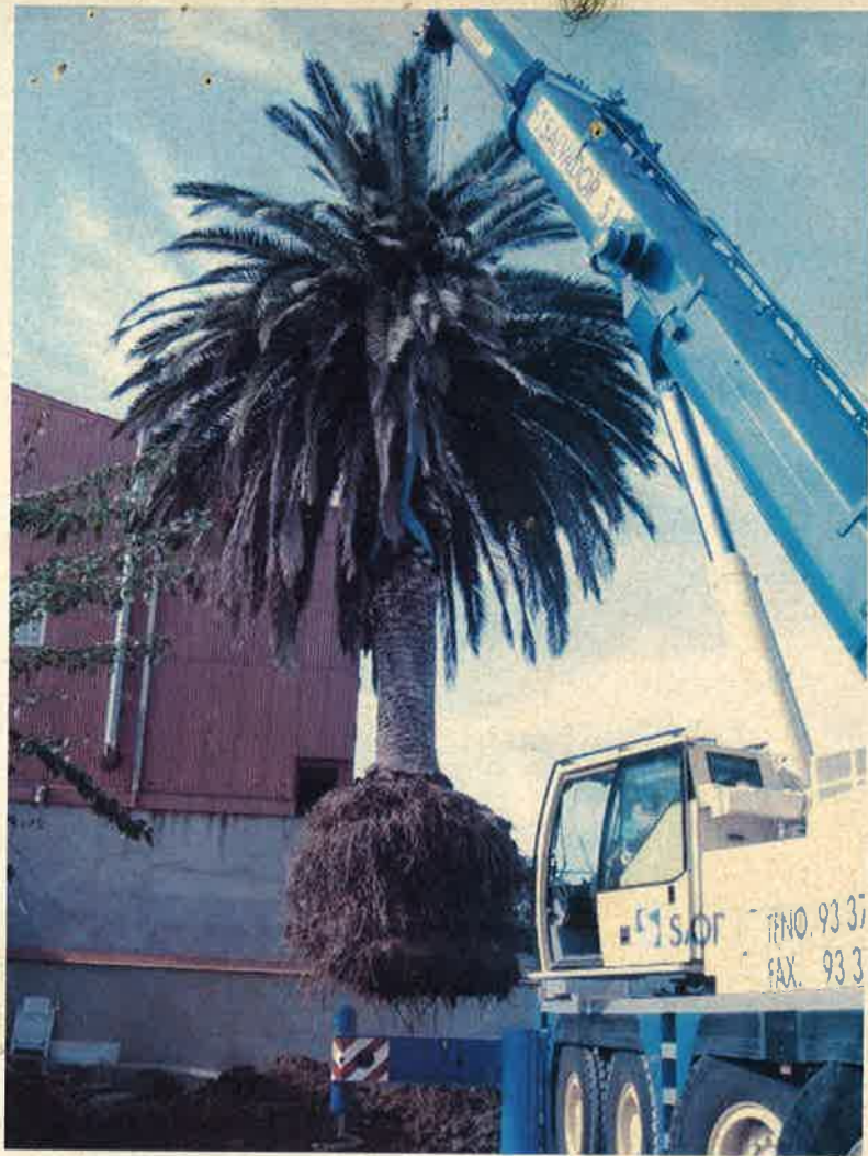
Complicada operación de retirada de una palmera de un patio privado, cerca del restaurante Casa Alcaide.
