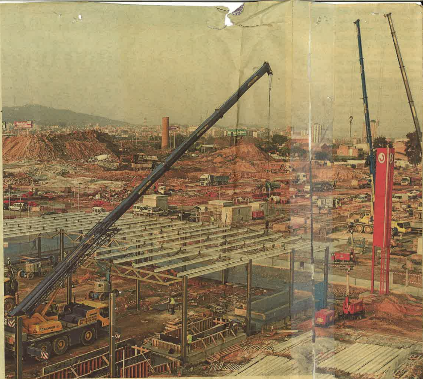
Una decena de operarios trabajaban ayer en la estación de El Prat. ALBERT GEA
